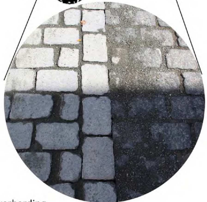
verharding type verharding, streven naar fietscomfort gezaagde kassei verhoogt het fietscomfort in vergelijking met de 'gewone' gekapte kassei
